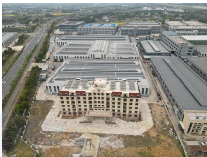
安徽恩诺光伏建设
